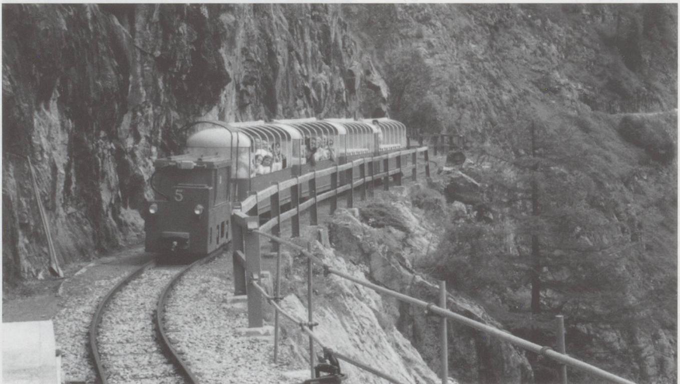
Pied du Barrage: TTE Ta 2/2 No.5 with a train from Château d'Eau
