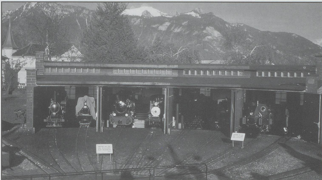
Vapeur Parc Suisse , Le Bouveret. The Shed. 28/04/01. Photo: Paul Russenberger
