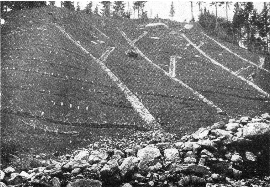
Fixation de sols humides en pente, au moyen de clayonnages horizontaux, les eaux s'écoulant le long de cunettes empierrées (Légion I, cohorte d'Udine).
