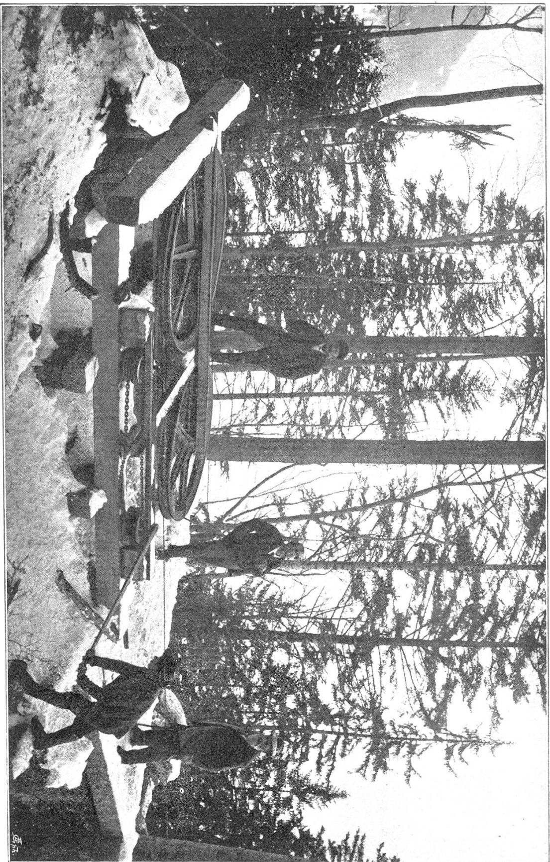
Bremsstation der Drahtseilriese zu Birkenthal bei Brienz. Trein du câble aérien de Birkenthal, près Brienz.
