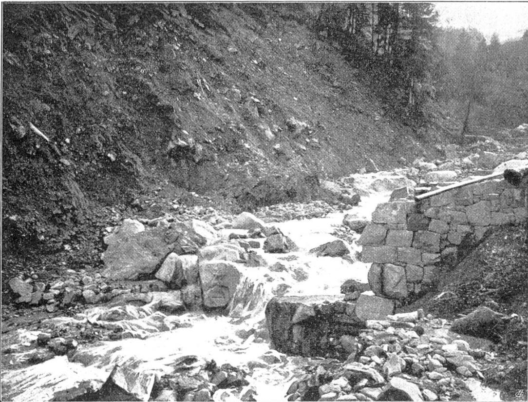
Zerstörte steinerne Sperrbauten an der Großen Schlieren bei Alpnach.
