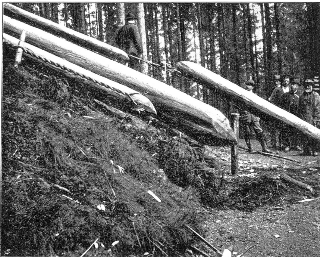
Bau einer Holzrieße.
