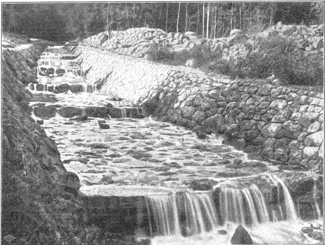
Abflussskanal des Biltener Dorfbaches.
