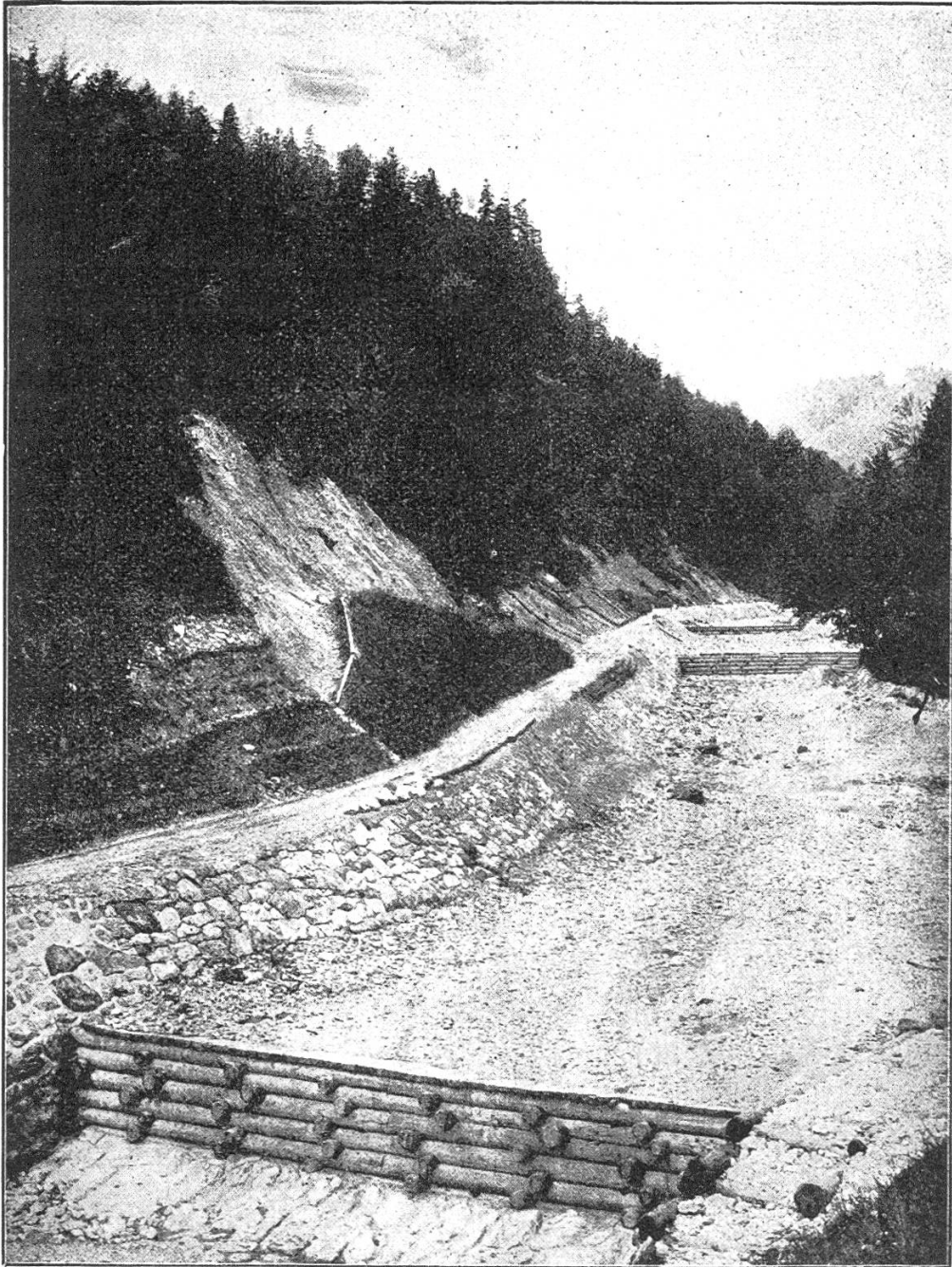
Fig. 2. Lehnsicherung durch Spreitlagendamm.
