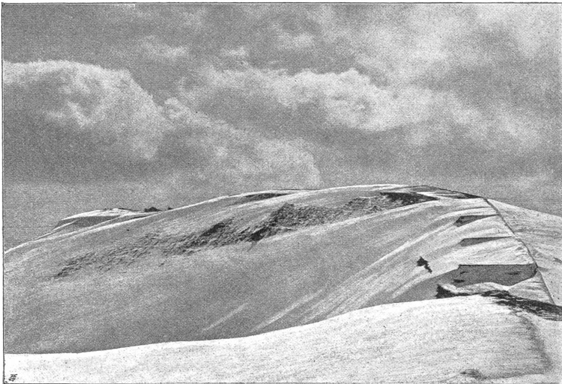
Fig. 6. Schneeablagern vor und hinter dem Lawinen-Schutzdamm.
