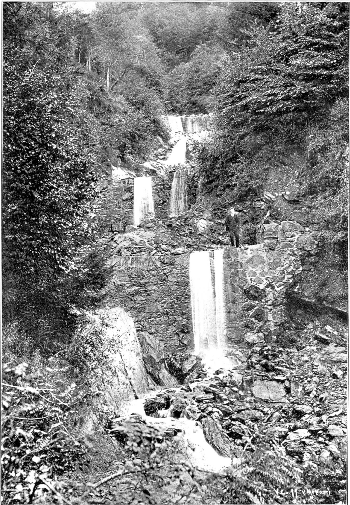
Einzugsgebiet des Cassarate, Val Colla. Aufforstung und Verbau, Val Savazè, Bogno.
