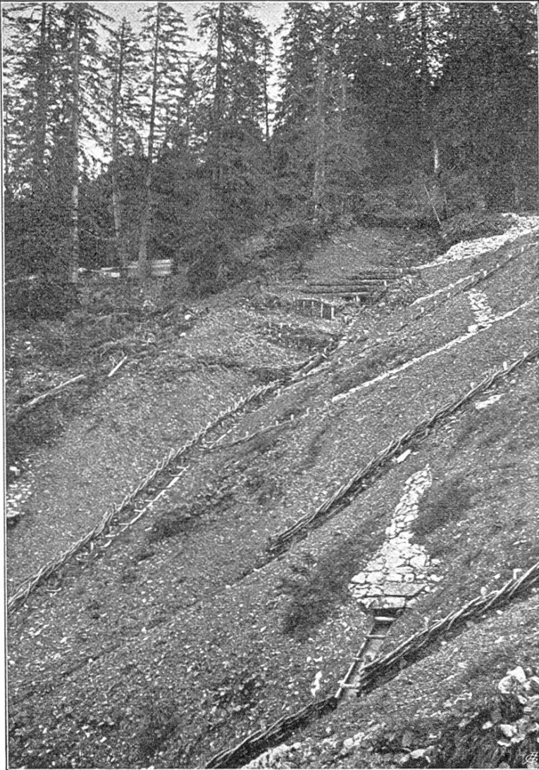
Fig. 4. Einzugsgebiet des Lungerer Dorfbaches: Konsolidierung einer Unbruchfläche durch Entwässerung.
