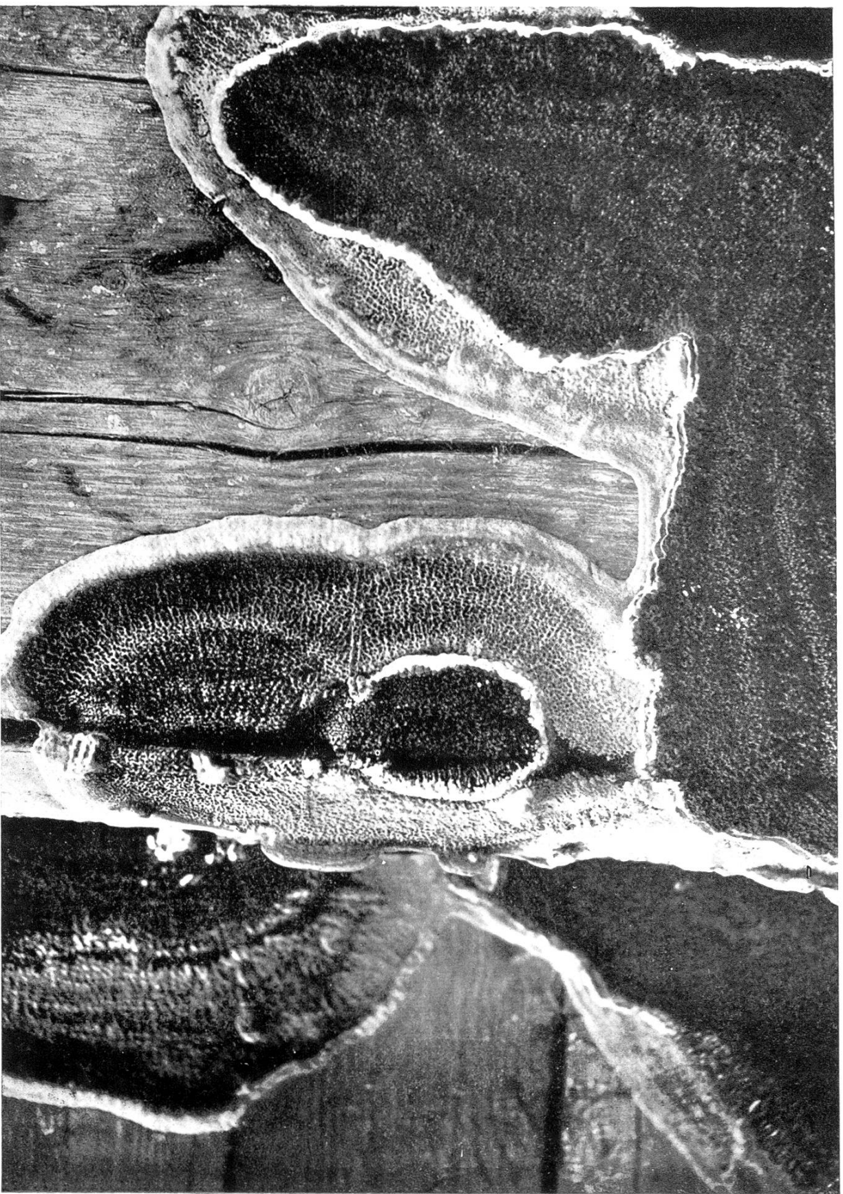
Fruchtkörper von Merulius domesticus (Salz) an einem Balken der Kellerdecke im Gartenhaus Möllisberg.
