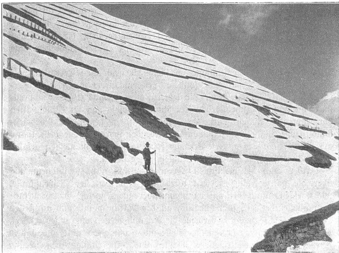
Fig. 5. Weizenplanke bei Elm. Mauerterrassen, gemischte Terrassen und schmälere Terrassen mit Pfahlreihen bei stark zurückgegangener Schneedecke.
