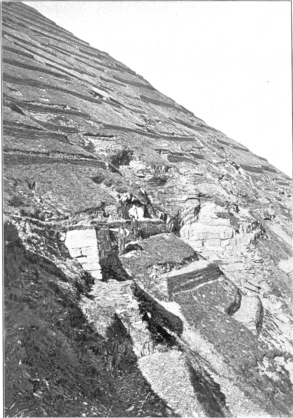
Sawinenverbau an der Meißenplanke bei Elm mittels gemischter Terrassen und einzelner Mauerterrassen
