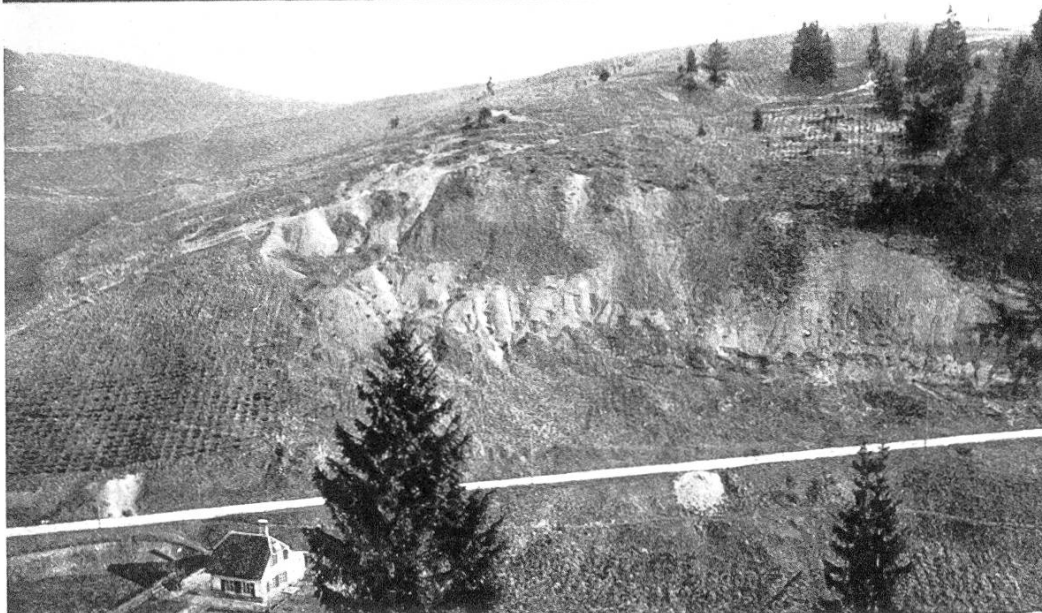
1906: Erosionsfurchen verbaut. Aufforstung be- gonnen
