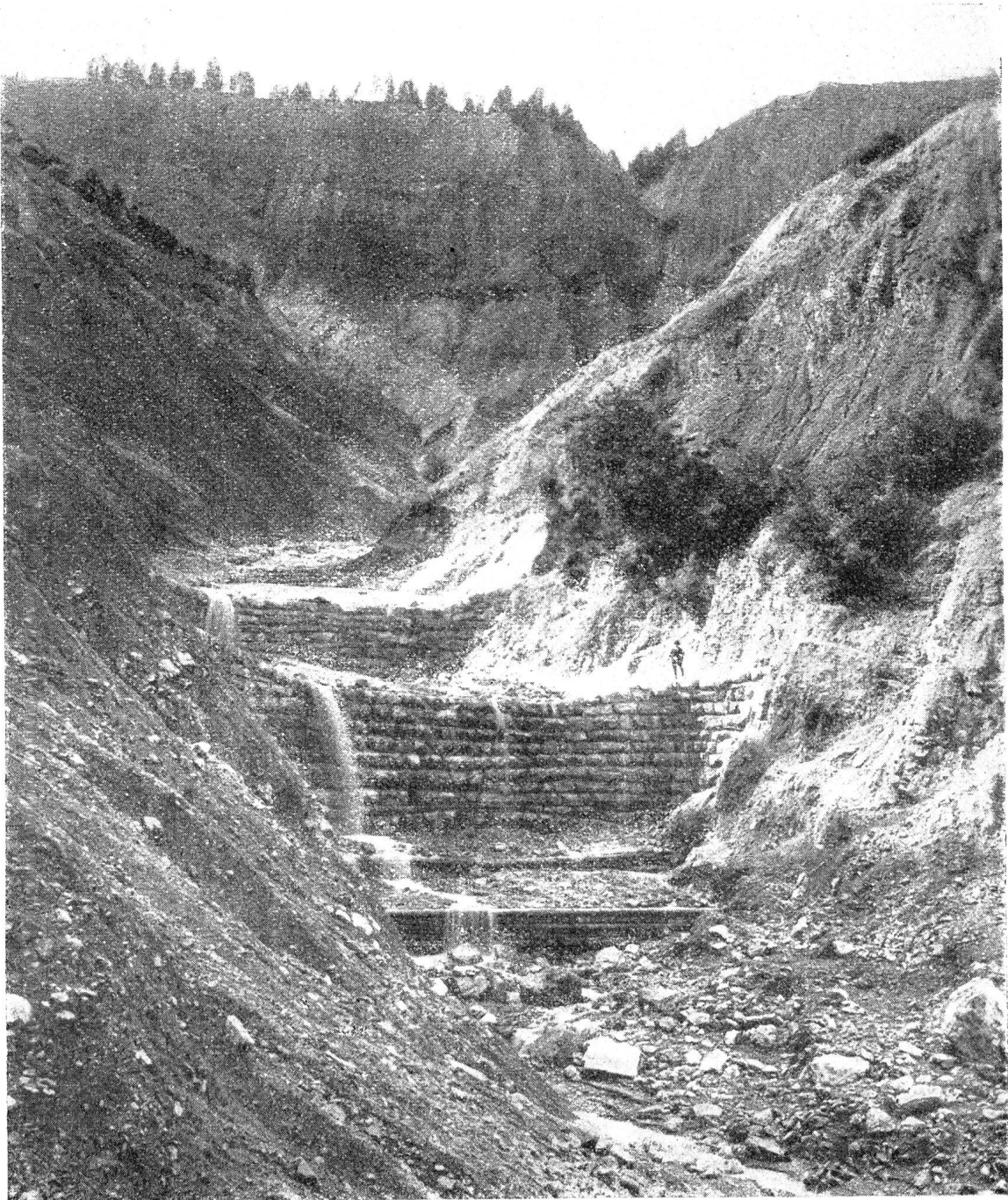
Abb. 6. Beginn der Staffellung im Profil IV. Sämtliche Sperren sind heute überdeckt. Im Hintergrunde ist die Baustelle der letzten großen Staffellung (Profil V) sichtbar.
