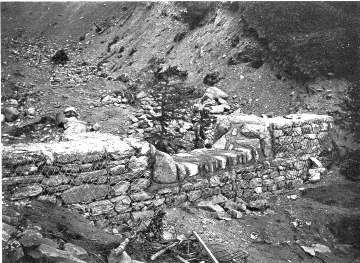
Abb. 4. Gitterkastensperre bei Olivone. Phot. Müller, 1930.
