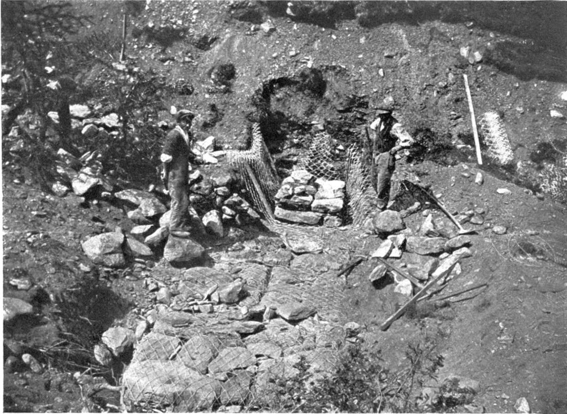
Abb 3. Bau einer Gitterkastensperre bei Olivone. Phot. Müller, 1930.
