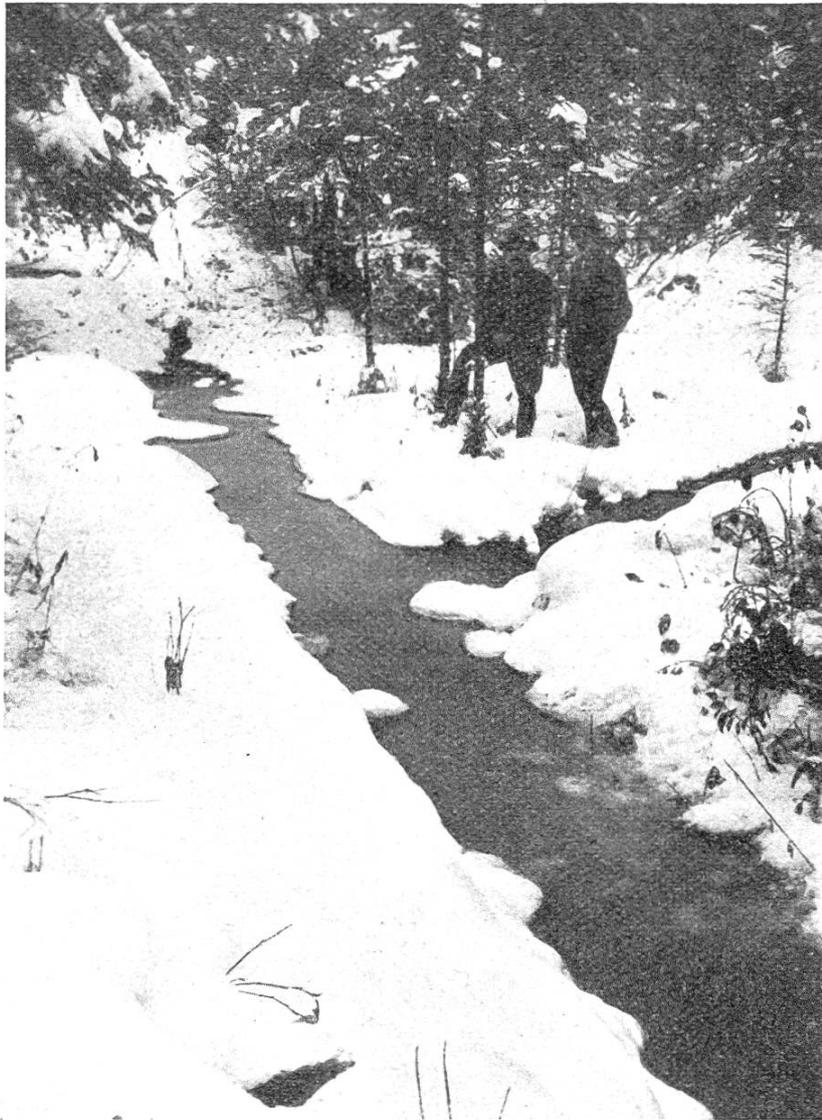
Abb. 1 a. Zufolge ungenügender Gefälle und nachträglicher Senkung des Bodens sind die Seitengräben (Nebenrinnen) nicht mehr imstande, sich zu entleeren.
