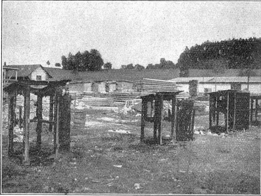
Abb. 10. Die Löscharbeit an den Objekten 5, 4, 3 und 2 beendet.
