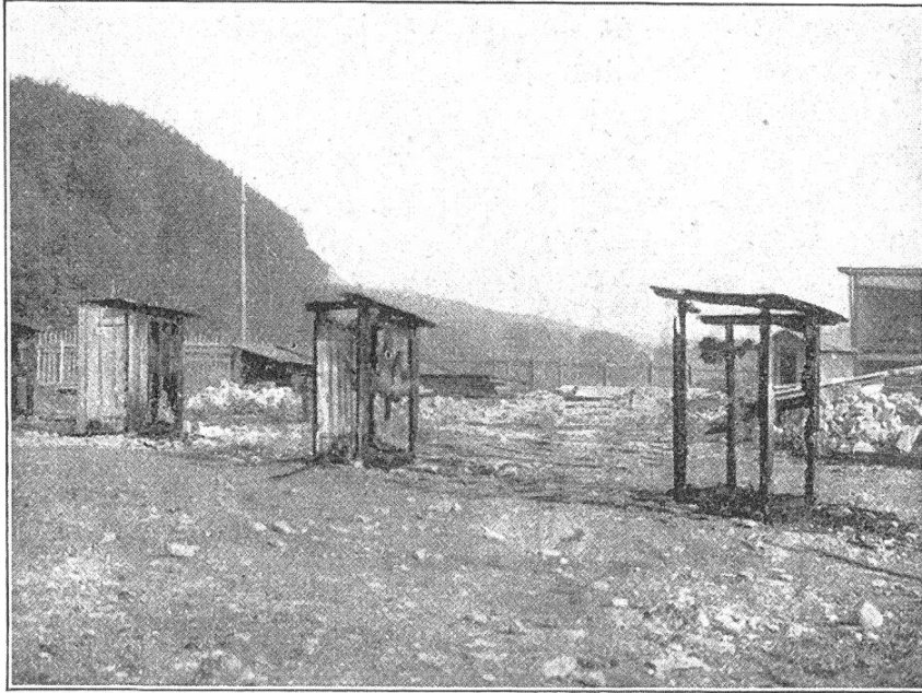
Abb. 14. Brandobjekt 1, 2 und 3 nach dem fertigen Löschen.
