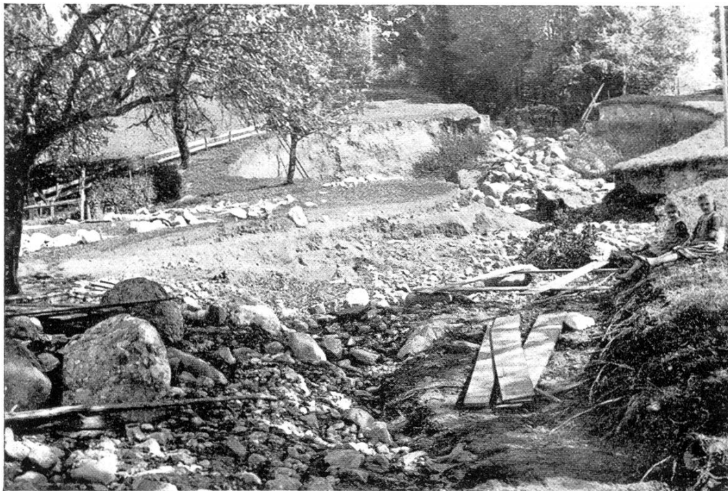
Abb. 3. Bei Winkel-Eierhals brach ein sonst harmloses Freilandbächlein aus und zerstörte einen Obstbaumgarten.
