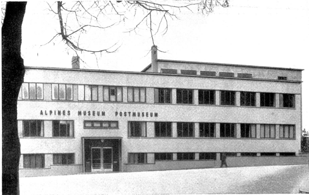
Südfassade. Aufnahme Photodienst der S B B.
