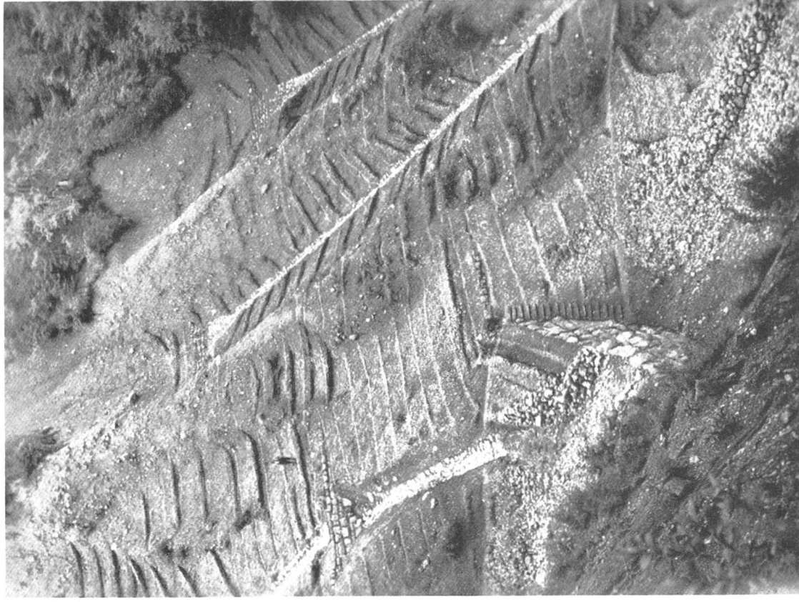
Phot. M. Kaiser, Oberförster. Bild 7. Verbauung derselben Rufe mit Hilfe von Trocken- mauern, Steinschalen und Flechtwerken in Verbindung mit Weiden und Weiserlen-Reihenpflanzungen. Aufnahme Sommer 1937.
