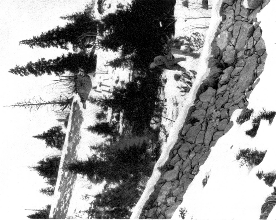
Phot. M. Kaiser, Oberförster. Bild 5. Im Vordergrund alte, freistehende, horizontallaufende Trockenmauer, erstellt im Jahre 1902. Im Hintergrund, quer zum Lawinenzug angelegte Mauerterrasse vom Jahre 1931 und dient zur Verstärkung der alten Lawinenverbauung des Jahres 1885—1910.
