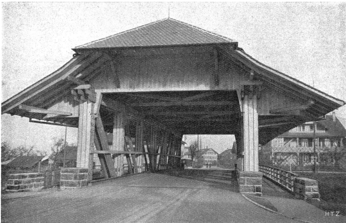
Die fertige Brücke vom linken Ufer aus gesehen.
