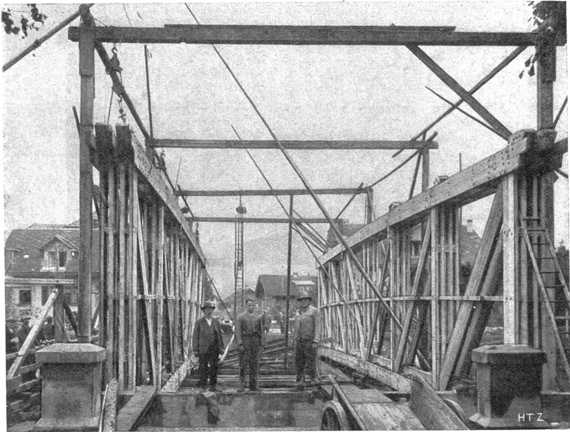
Die fertig montierten Hauptträger; 7. Oktober 1937.
