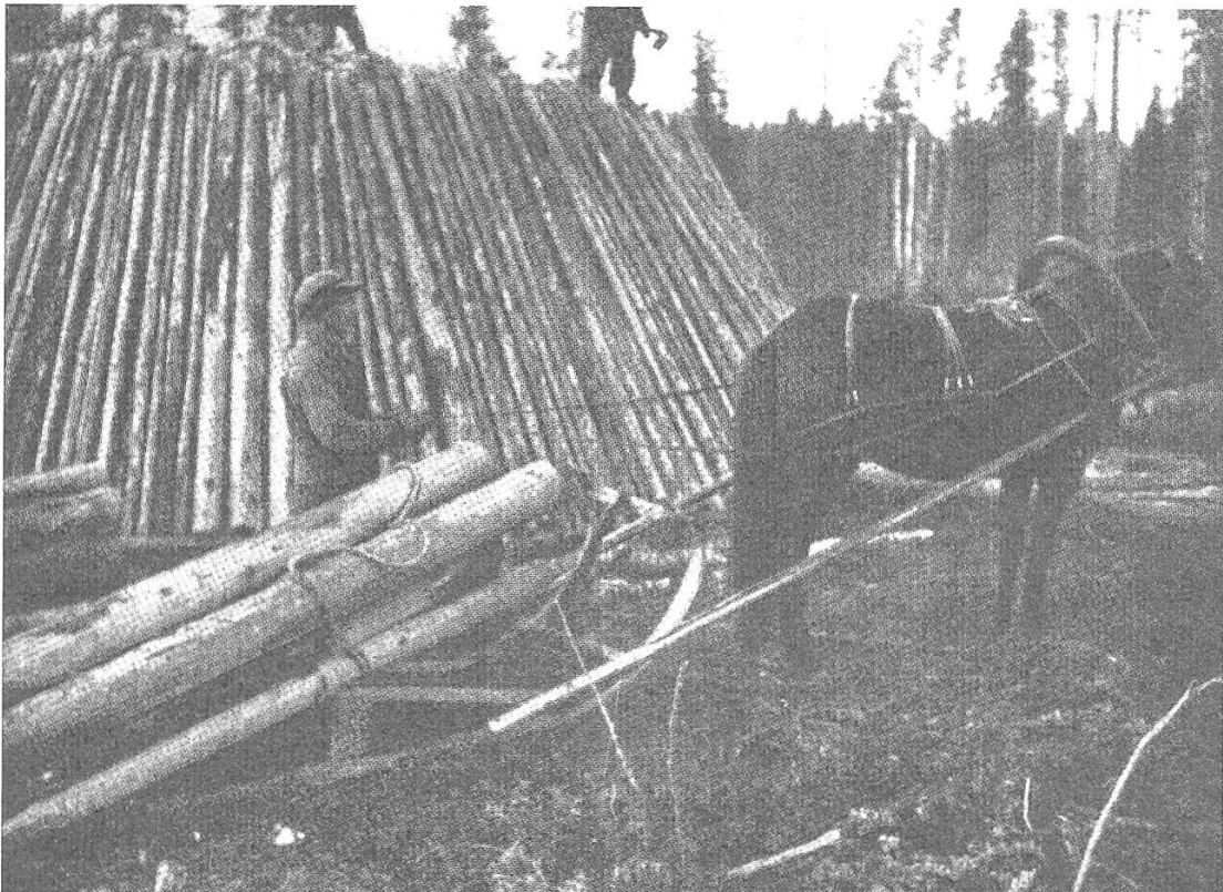
Bild 2. Aufstellung eines Meilers aus 3 m langem Durchforstungsholz.
