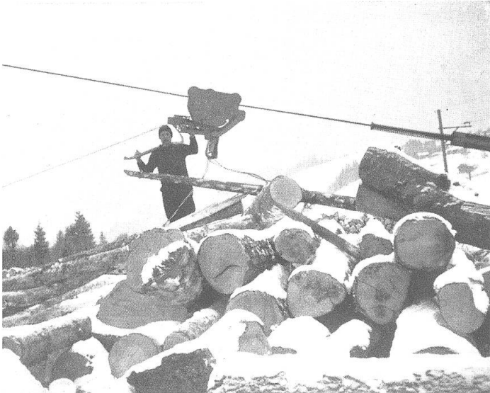
Bild 10. Durch Oeffnen des Schliessbügels wird an der Talstation die Last vom Laufwagen gelöst.
