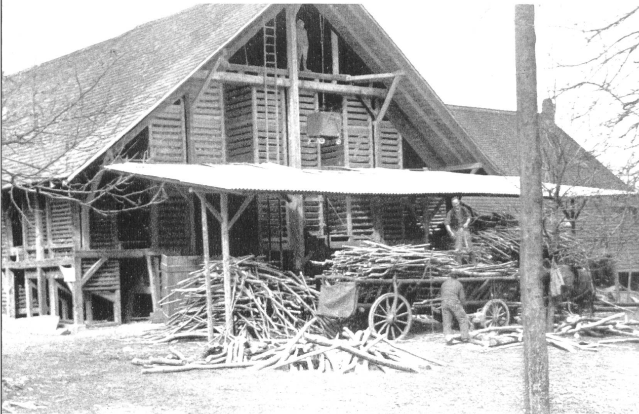
Bild 5. Die alte Ziegelei Neunkirch, in eine Trocknungsanlage für Gasholz umgebaut, 1939.
