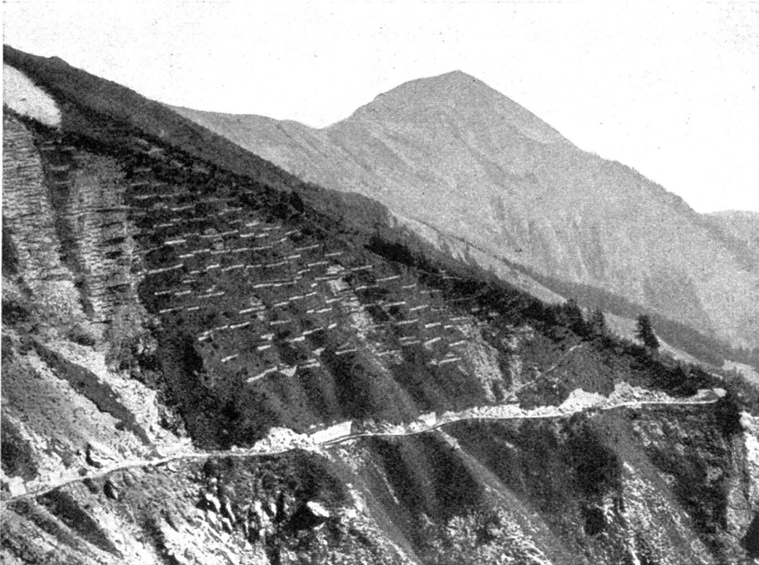
Lawinenverbau im Einzug des Lambaches im Gebiet der Briener Wildbäche.
