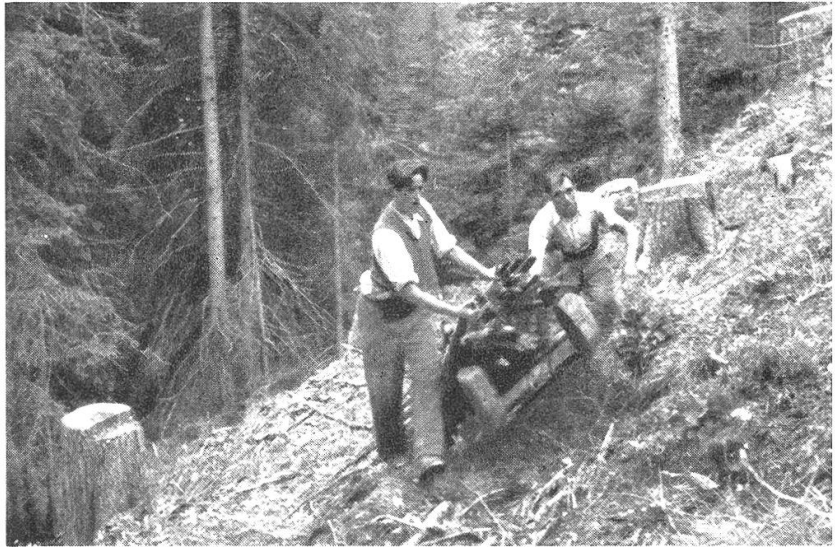
Aufwärtstransport auf dem Schlitten mit Motorzug.
