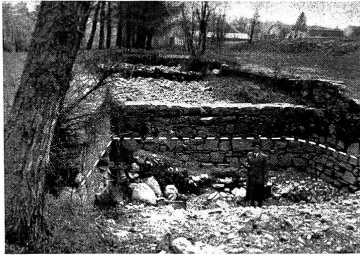
Abb. 7. In der Natur beobachteter Kolk ; die gestrichelte Linie gibt die Höhenlage der « natürlichen Gegenschwelle » an.
