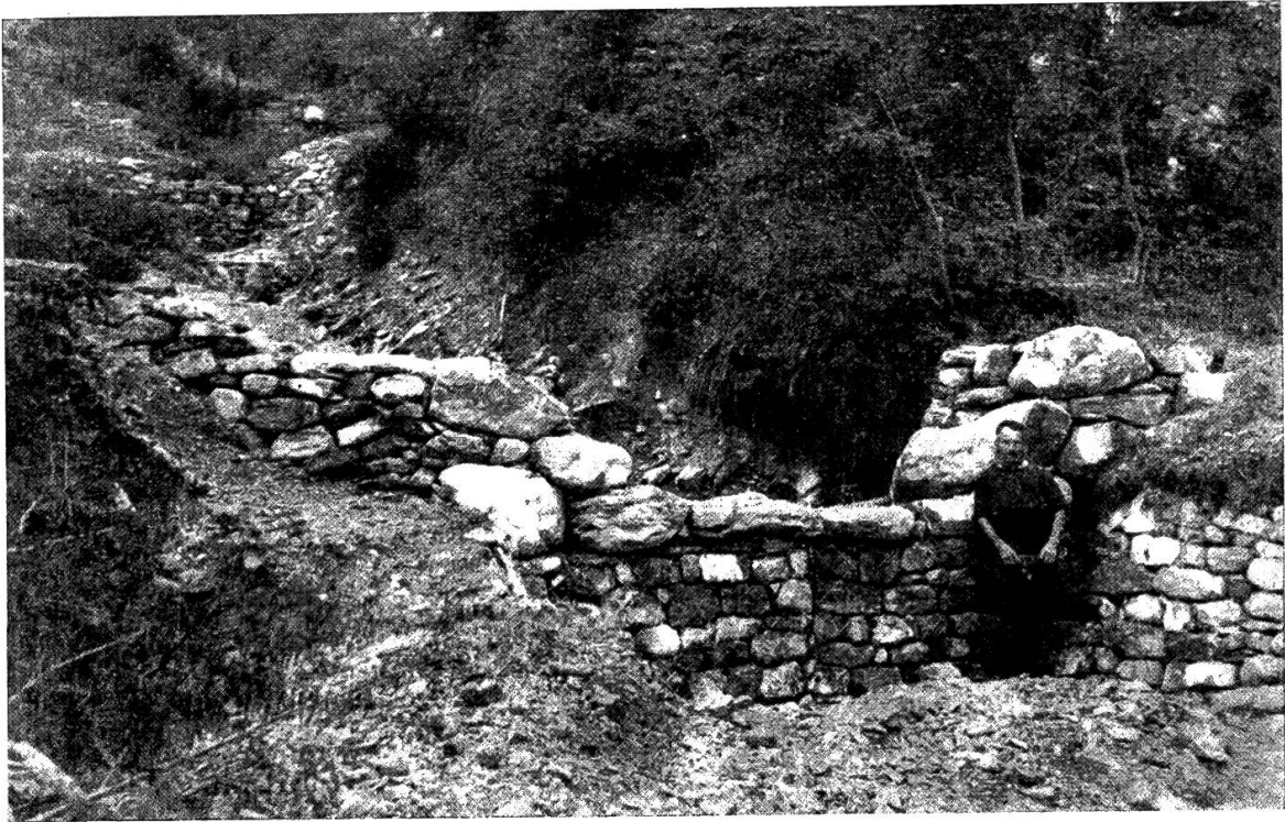
Steinsperre im Weidgraben: Drahtgitter-Mauerwerk und einfaches Trocken-Mauerwerk (Flügel). (Foto M. Oe.)
