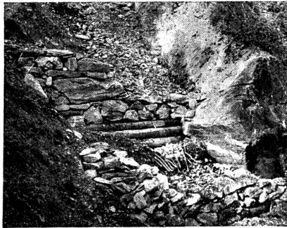
Gemischte Holz- und Steinschwellen im Rämsengraben. (Foto M. Oe.)
