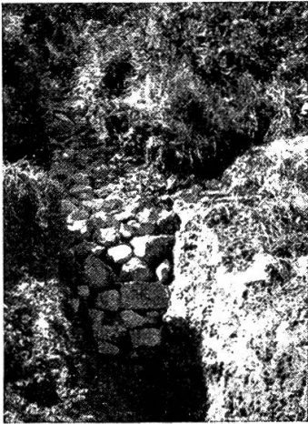
Ende einer Sickerdole mit Steinpackung. (Foto M. Oe.)
