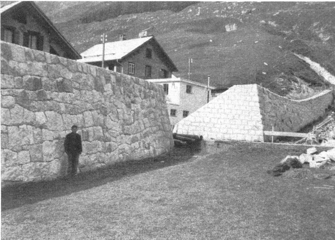
Straßendurchgang zwischen den Mauern II und III
