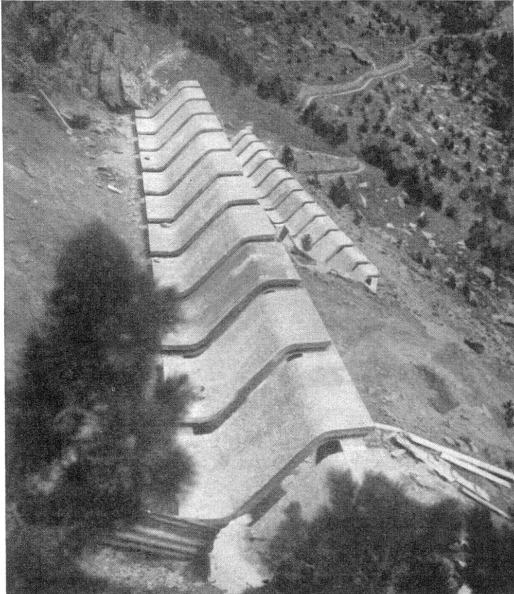
Figure 2 Râteliers en béton armé
