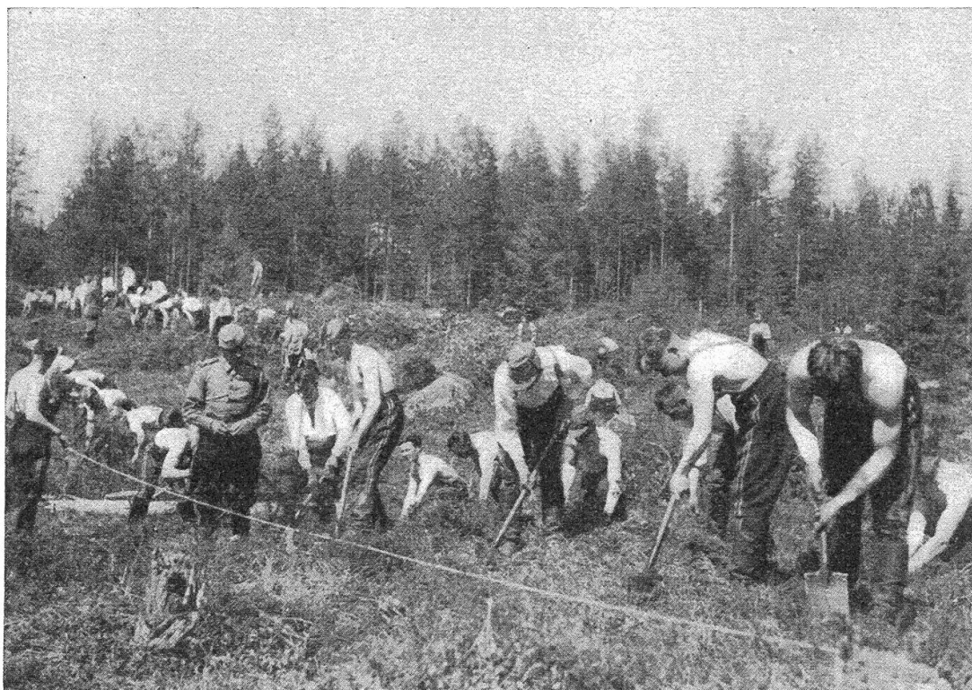
Pflanzenarbeiten der Kavallerie unter Leitung von Offizieren und Forstbehörden
