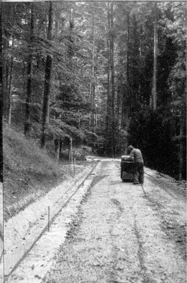
Feststellung, daß durch die Kalkbeimischung eine derart zähe, feste Lehmdecke im Boden entstanden war, daß beim Befahren mit beladenen Fahrzeugen der plastische Untergrund wohl unter den Rädern einsank und dazwischen gehoben wurde, ohne daß aber die zähe Oberflächendecke brach oder riß.
