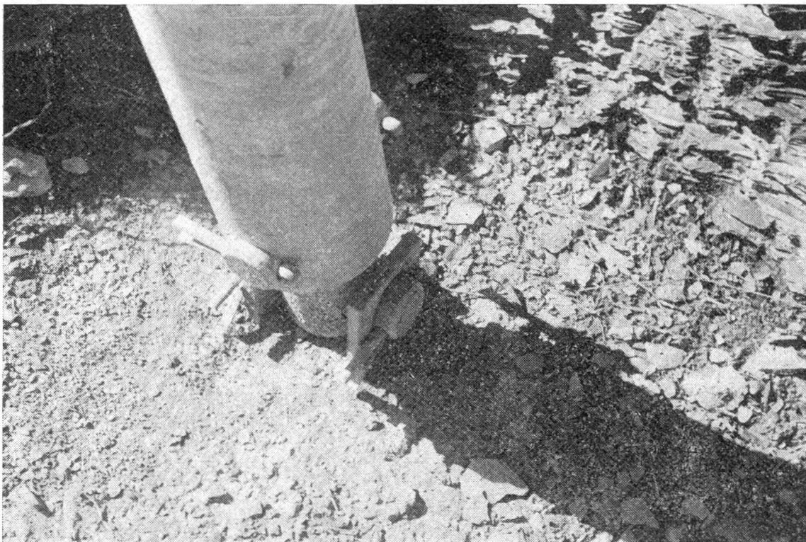
Kreuzgelenkstütze für Schneenetze. (Photo: H. Oppliger, Glarus)
