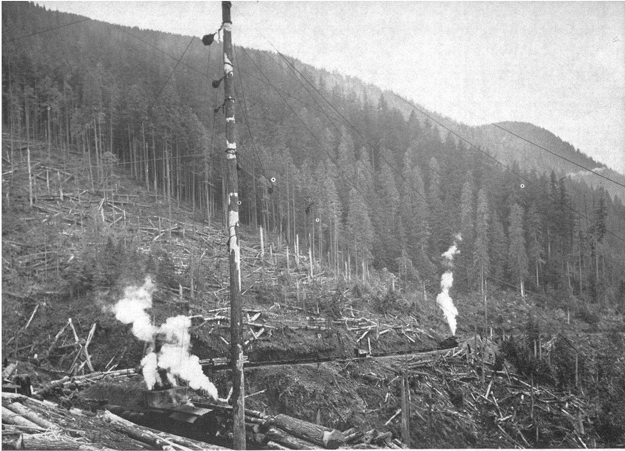
Bild 2. 1936: Kahlschlag mit Zuziehen des nutzbaren Holzes auf kurze Distanz mit dem «Spar-tree-System». Transport mit der Waldeisenbahn, die mitten in die exploitierte Fläche hineingeführt wird. 1974 ist der «Spar-tree» im Versuchswald der Universität von British-Kolumbien auf ein ehemaliges Tank-Chassis aufmontiert.
