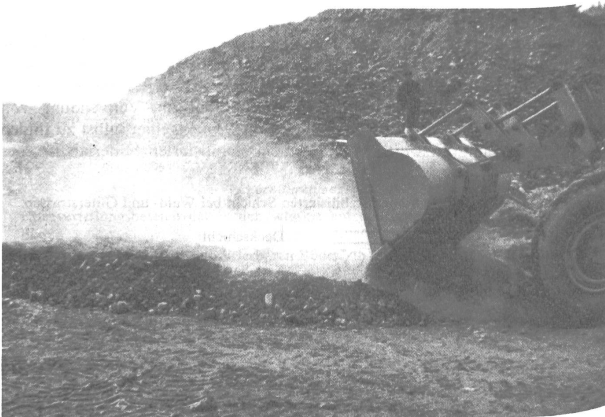
Darstellungen 8 und 9. Ladeschaufel beim «Verteilen» von Zement und «Mischen» von Kies-Sand und Zement.
