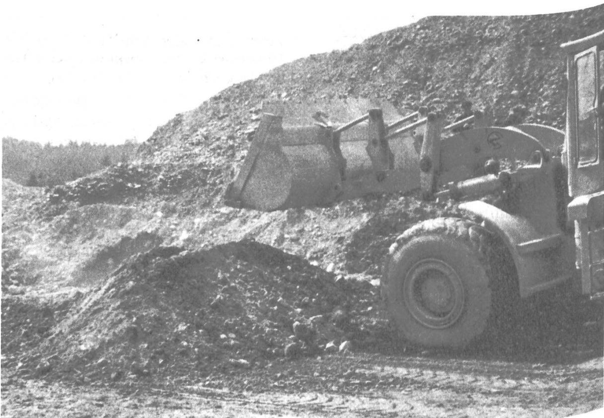
etwa doppelt so hoch wie der eines guten, von Natur aus stabilen Kiesel (a-Wert des stabilisierten Materials zirka 0,20). Anstelle mehrerer Schichten wird daher in Zukunft die gesamte Tragschicht vermehrt nur noch aus zementstabilisiertem Material bestehen. Der ganze Arbeitsablauf, insbesondere auch der Einbau des Materials, wird dadurch wesentlich vereinfacht.
