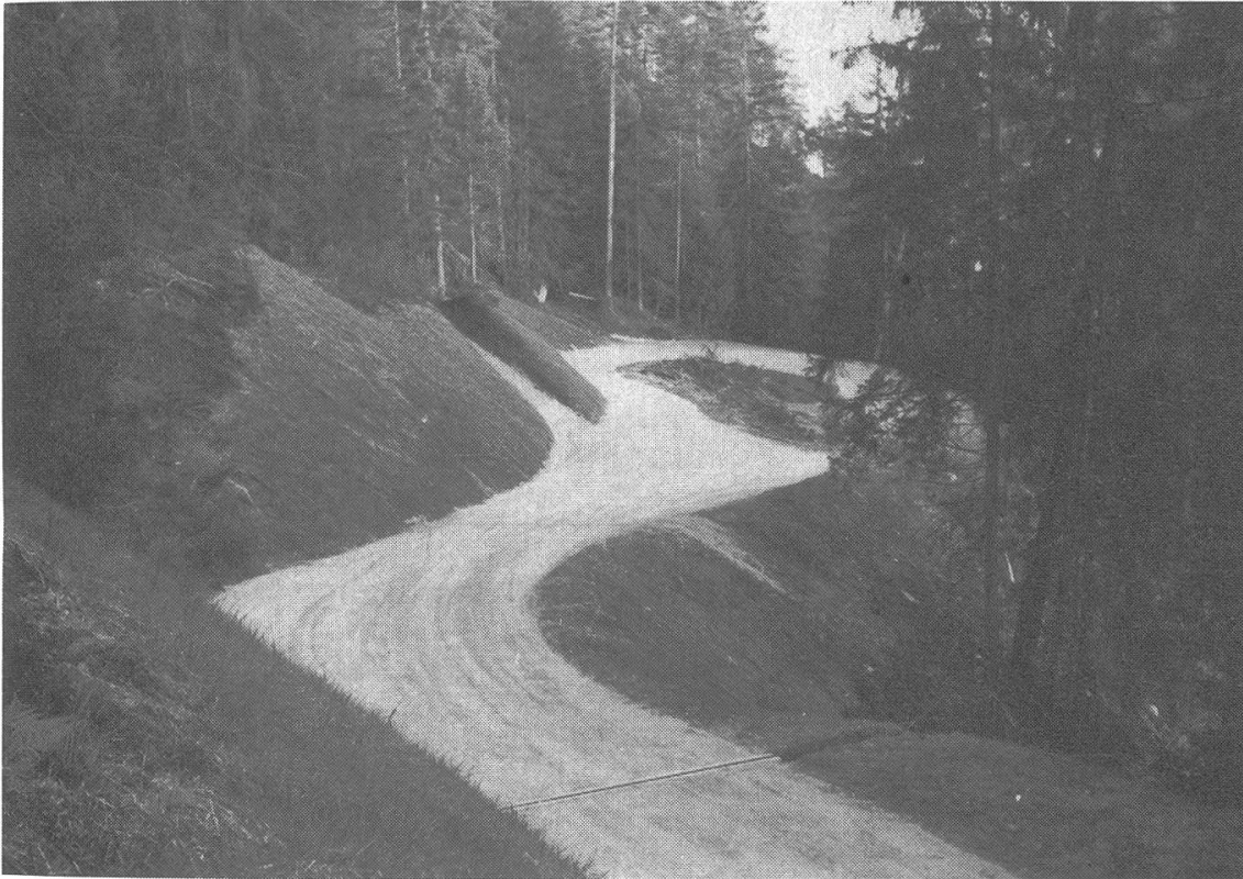
Abbildung 2. Der alte Schlittweg (Bildmitte) wurde vorbildlich an den neuen Waldweg angeschlossen, so dass er von Wanderern weiterhin benützt werden kann. (Foto Calörtscher)
