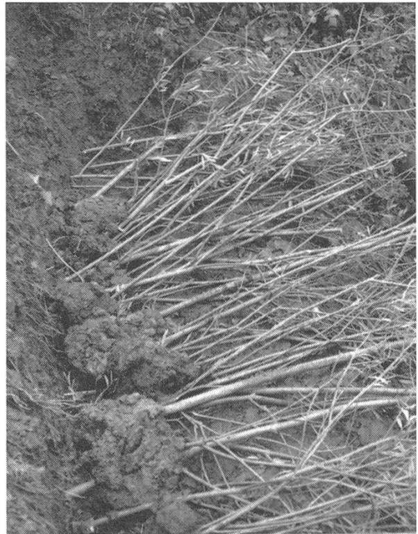
Abbildung 3. Buschlage: Auf einer Berme von rund 50 cm Breite, die gegen den Hang geneigt ist, werden Weidenäste kreuzweise verlegt. Mit dem Aushub für die nächste Lage wird die unten liegende wieder eingedeckt. Abschliessend sind die vorstehenden Triebe auf etwa 15 cm zurückzuschneiden.
