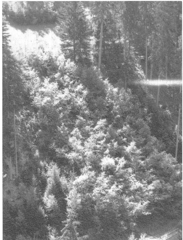
Abbildung 4. Heckenlage: Der Unterschied zur Buschlage besteht darin, dass anstelle von Weidenästen bewurzelte Pioniergehölze eingelegt werden. Der Hang wurde vor 15 Jahren mit einer Druckleitung durchquert. Heute sehen wir einen aus Heckenlagen hervorgegangenen Erlenbestand, der mithilfe, die Schneise raschmöglichst zu schliessen.
