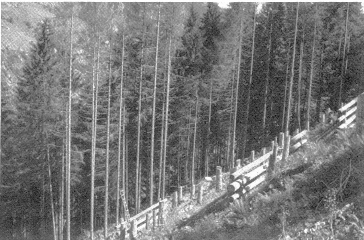
Abbildung 2. Borkenkäferflächen im Baumgartiwald behelfsmässig verbaut.
