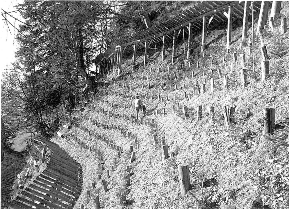
Abbildung 7. Versuchsfläche für Schneegleitschutzmassnahmen, Detailansicht (Bleisa/Pusserein, GR).
