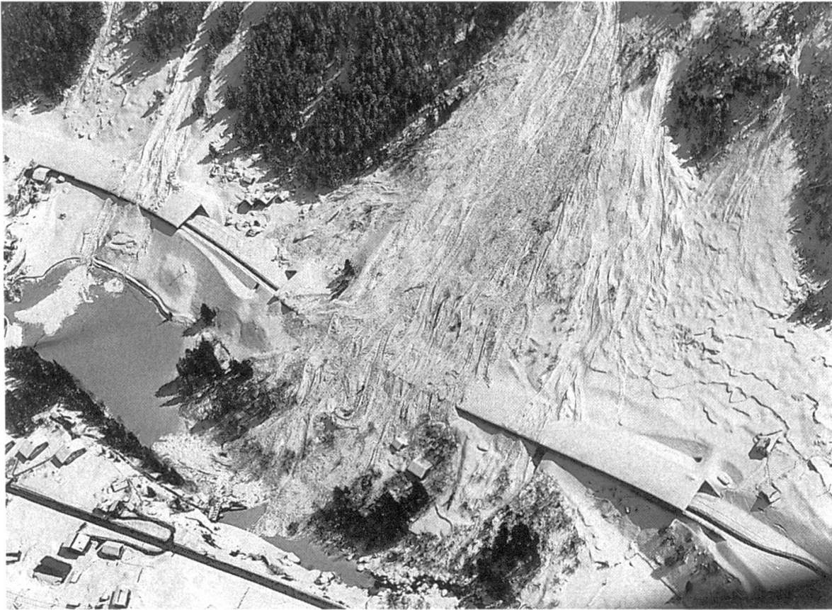
Abbildung 2. Lawinengalerie (Pfaffensprung bei Wassen, UR, 8. April 1975).
