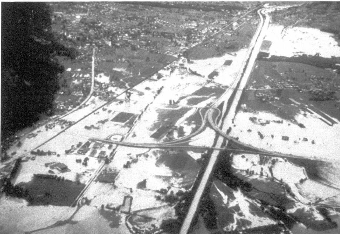
Abbildung 1. Überschwemmtes Reusstal bei Flüelen am 24./25. August 1987. Aufnahme: Kantonales Bauamt Uri.
