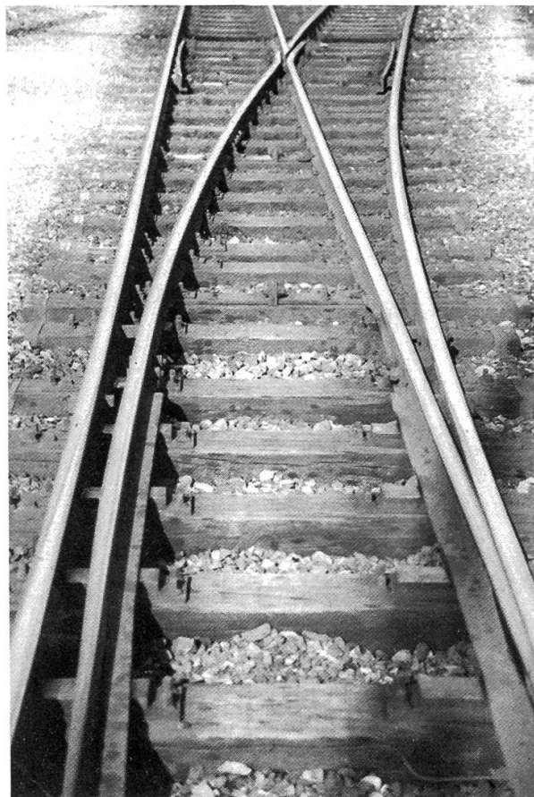
Abbildung 3. Holzschwellen im Eisenbahnoberbau.
