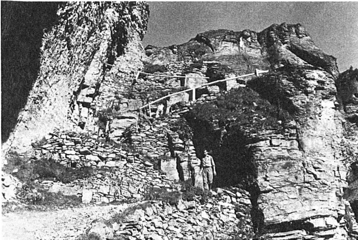
Abb. 21. Gemmi-Südseite, Warms Loch (Tafel 3, Ziffer 18). Gebauter Weg von 1739–43, mit bautechnisch und topographisch ausgeglichener Steigung. Wegoberfläche kiesig, Randpflaster steil eingesetzt. – In Abb. 22 ist ein steingerecht gezeichneter Ausschnitt aus dem Raum des ersten Holzpfostens vom linken Bildrand her dargestellt. Aufnahmemitte Az 6250 A‰. (Aus AERNI 1971, Abb. 29.)
