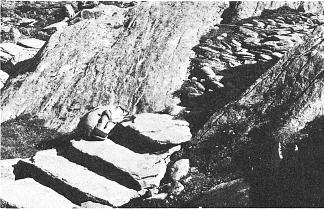
Abb. 2. Monte Moro – Nordseite: Alp Distel. Ein kerbförmiger Einschnitt zwischen grossen Blöcken wurde durch den Einbau flacher Platten (Treppenfliess) und kleiner, steilgestellter Platten (Steilfliess) begehbar gemacht. Dieses kleine Wegstück ist als «gebauter Weg» zu bezeichnen, der übrige Teil des Passweges gehört in der Mattenstufe zum «gewordenen» und «gebahnten» Wegtypus. – Standort: LK 1349 – 640 800/96 600 / 2225 m; Bildmitte Az ca. 2400 A‰. (Aus AERNI 1971, Abb. 3.)
