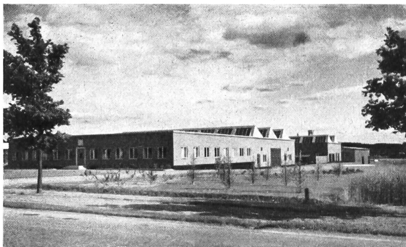
Les nouveaux bâtiments des établissements d'Ultuna.
