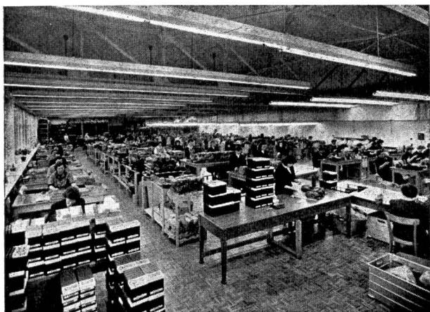
Abb. 2 Reine Allgemeinbeleuchtung mit Fluoreszenzlampen in Reflektoren (im Hintergrund arbeitsplatzorientierte Allgemeinbeleuchtung, der Arbeit besonders angepaßter Lichteinfall durch entsprechende Neigung der Reflektoren)
