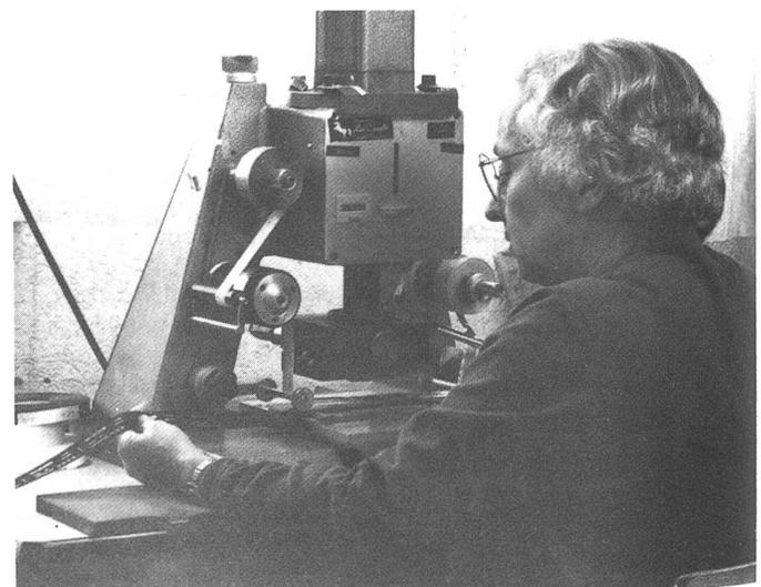
Auf Grund des bereinigten Entwurfes wird der Druckstock erstellt. Nun ist es Sache des Druckers, Cliché, Farbe und Druckgut so in die Maschine einzugeben, dass sie die fertigen Etiketten Stück für Stück – einzeln geschnitten oder am laufenden Meter – in gleichmässig guter Ausführung auswirft. Sauberes Arbeiten, gründliches Reinigen von Maschine und Werkzeugen sind wesentliche Voraussetzungen für das gute Resultat.
