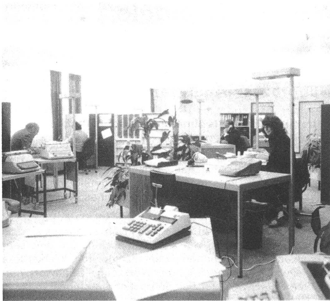
Bild 6: Grossraumbüro mit arbeitsplatzorientierter Indirektbeleuchtung durch hochstrahlende Tischleuchten mit Halogen-Metaldampflampen. Man erkennt deutlich die lebendige Helligkeitsverteilung an der Decke und die Reduktion der Beleuchtung in der Hauptverkehrszone (rechts). Die Leuchten selbst (z.B. links vor der Pflanzengruppe und über der rechten hinteren Ecke des rechten Schreibtisches) fallen fast nicht auf.
