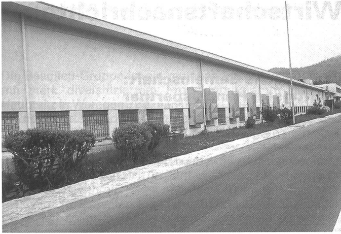
Die bereits renovierte Fassade des Webereigebäudes
