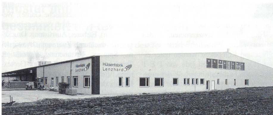
Neubau der Hülsenfabrik Lenzhard
