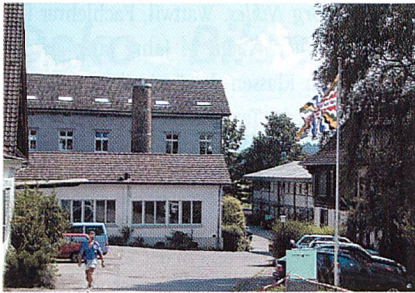
Fabrik- und Bürogebäude im Jahr 2000, Ansicht von Norden
